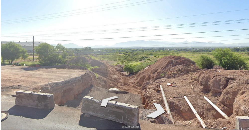
Imagen 32. Escurrecimiento que atraviesa el predio. Fuente: Google Earth, captura diciembre 2021.
